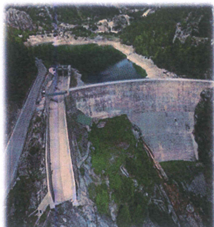
BARRAGE DES MESCES
